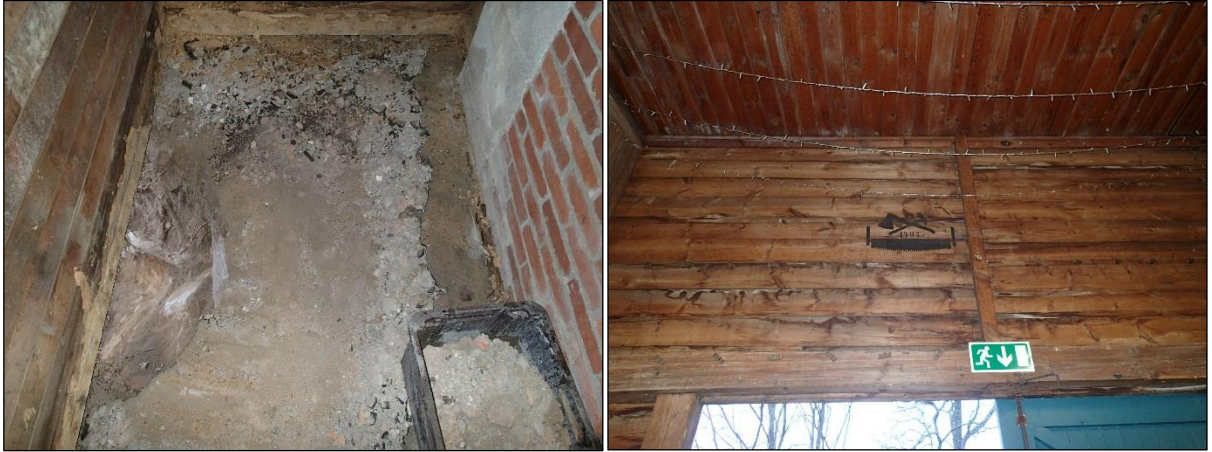
Vasemmalla: Lämpöputken sisääntulon kohta makasiinirakennuksen sisällä. Puoliympyrän muotoisessa avanteessa näkyy Y4:n kiviä makasiinin kaakkoisnurkan alla. Oikealla: Makasiinirakennuksen ulko-oven yläpuolella olevan merkinnän mukaan rakennus on valmistunut vuonna 1908.
