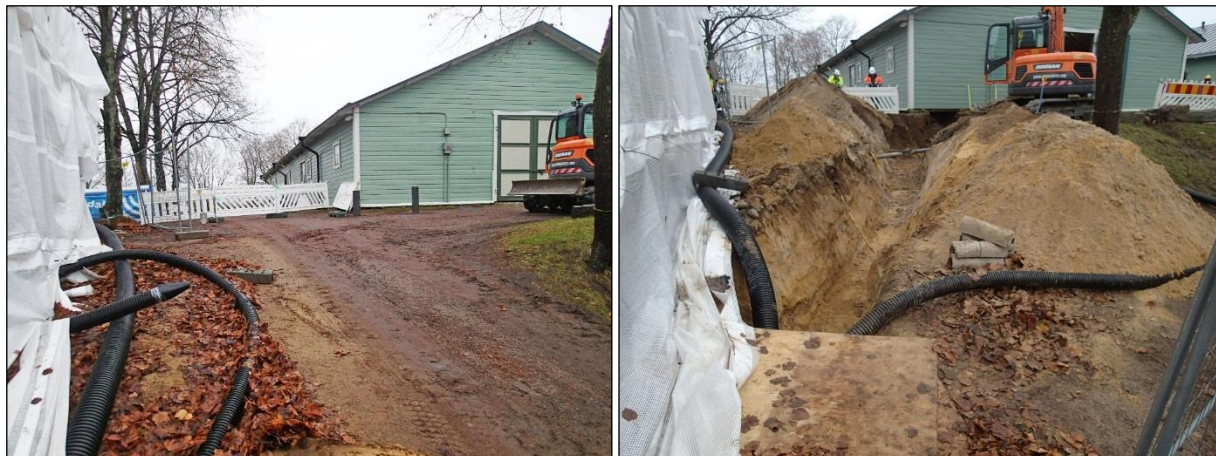
Vasemmalla: Luoteeseen. Valvottu osuus ennen kaivua. Taka-alalla vihreä makasiinirakennus ja vasemmassa reunassa Ratsuväkimuseon seinustan rakennustelineet. Oikealla: Kaivun jälkeen.
